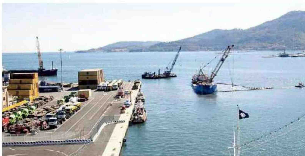
Operazioni di dragaggio nel porto della Spezia
